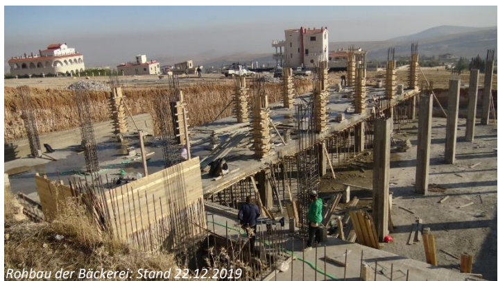
Rohbau der Backerei; Stand 22.12.2019
